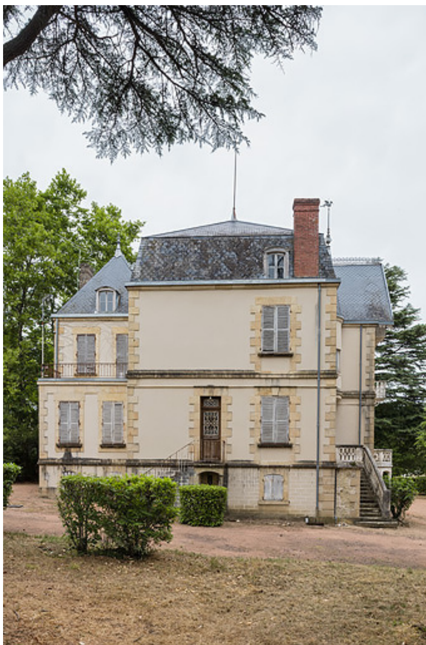
Élévation sud-ouest, vue depuis le sud-ouest.
