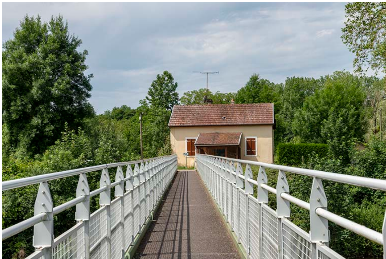
Vue de détail de la passerelle.
