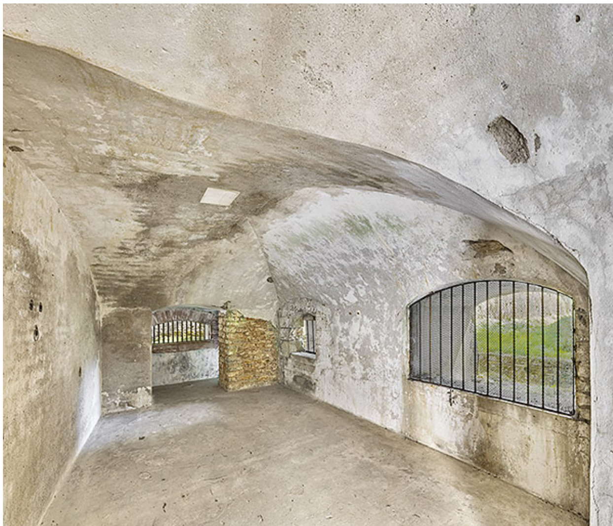
Vue intérieure de la double caponnière.
