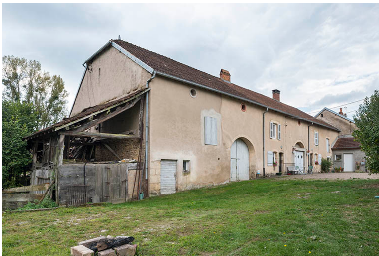
Alignement de fermes, rue de la Fontaine.
