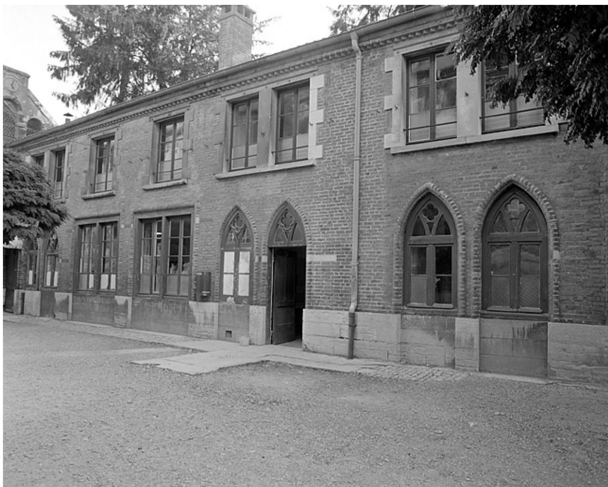
Bâtiment annexe, détail.
