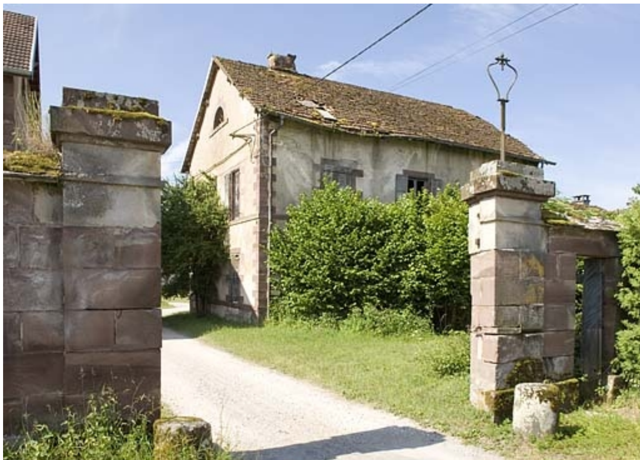
Piliers d'entrée et pavillon ouest.
