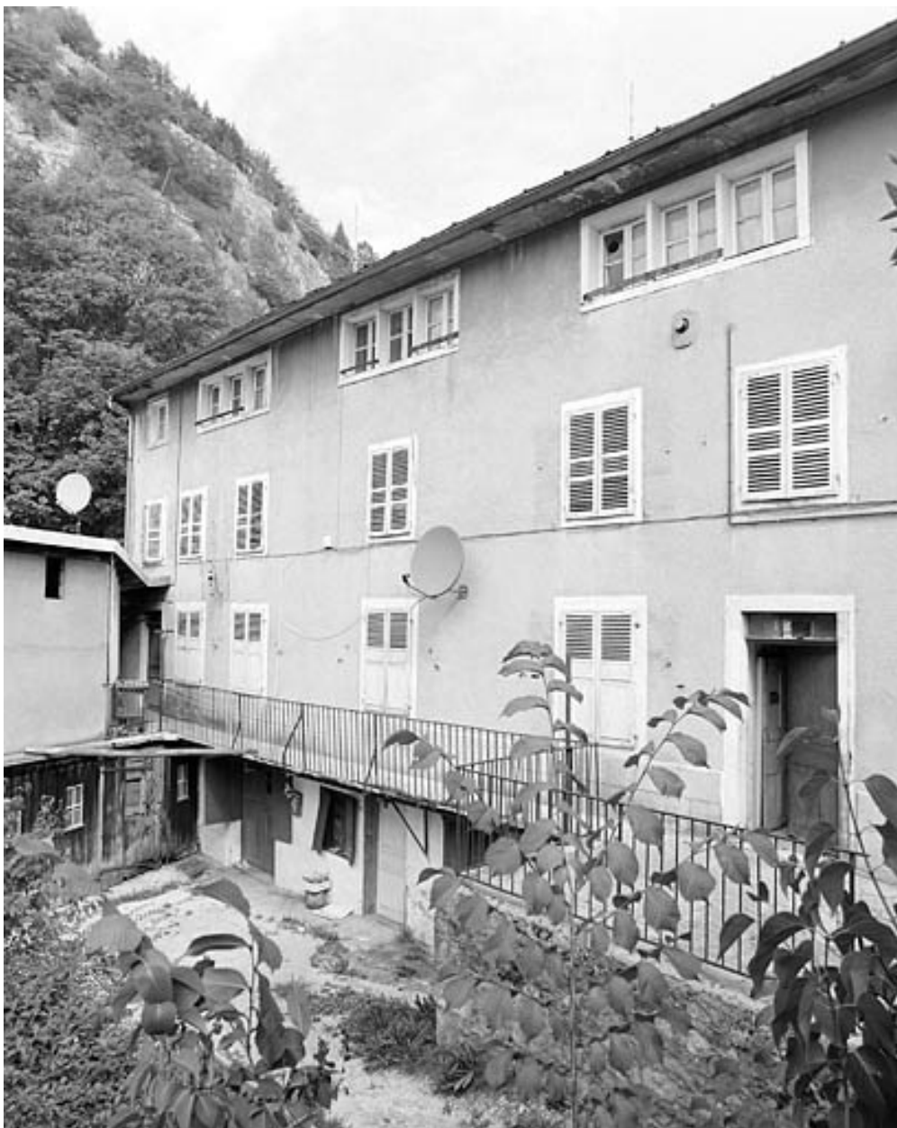
Façade principale : extension de 1861.
