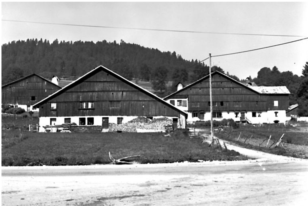
hameau des Cordiers : façades antérieures des fermes.
