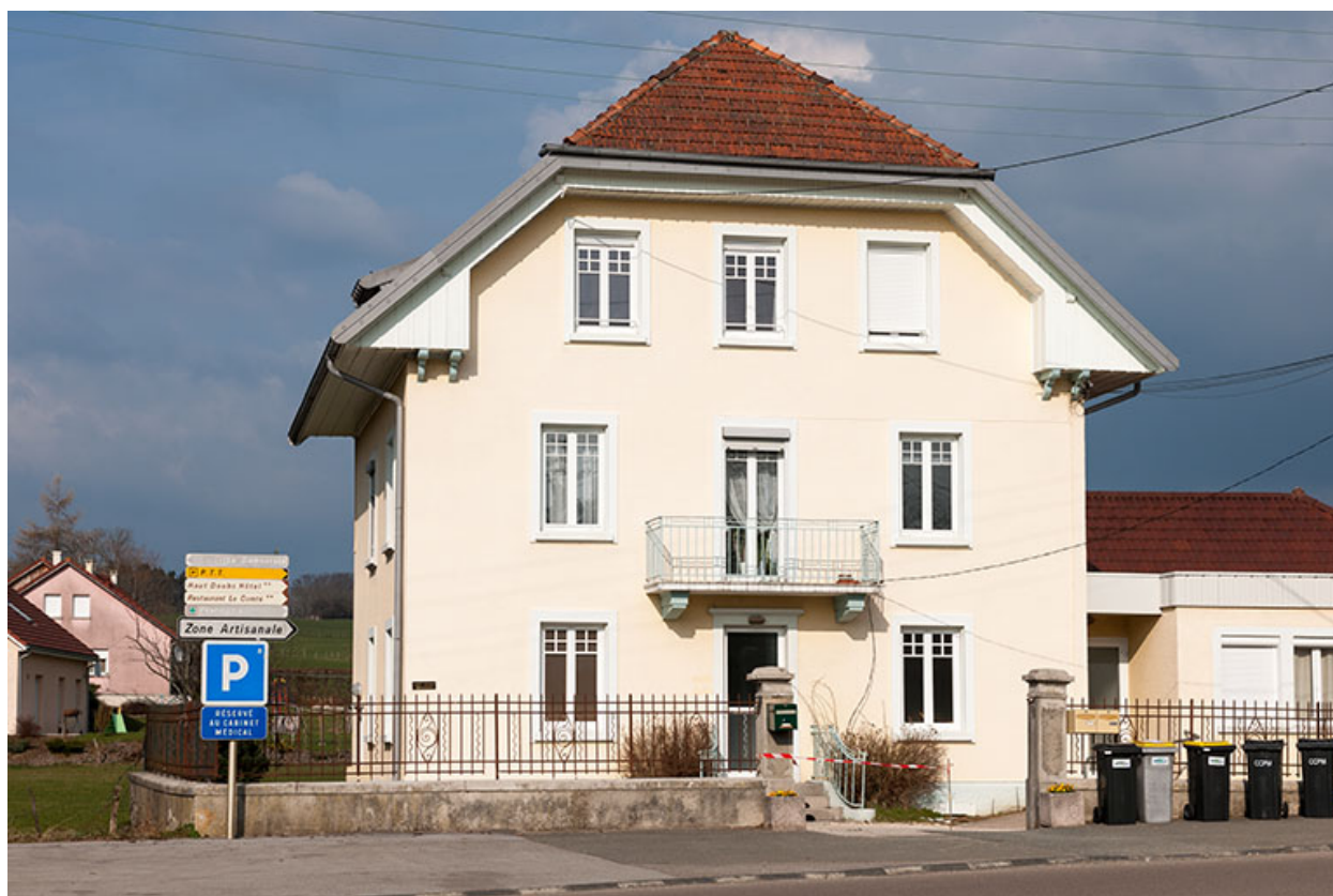
Façade antérieure du logement patronal.
