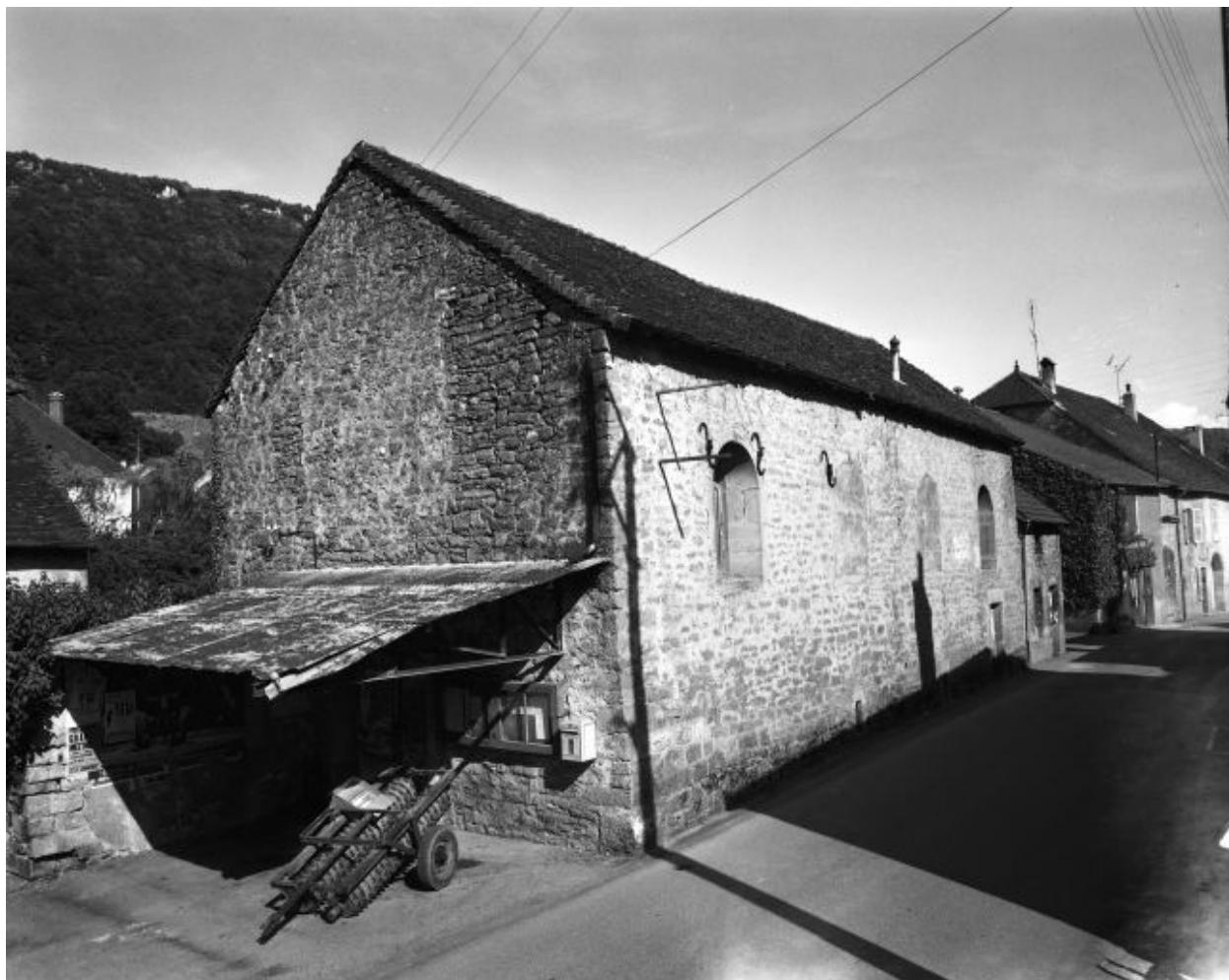
Eglise paroissiale Saint-Joseph, actuellement fromagerie (bâtiment situé à l'angle de la rue du Quart aux Veaux et de la route de la Vallée).
