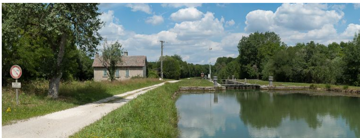
Vue du site d'écluse depuis l'amont.
