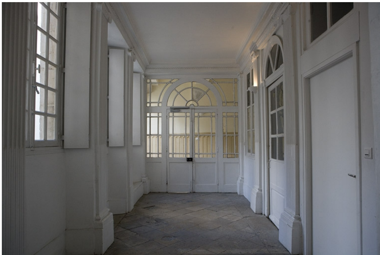
Vue d'ensemble du vestibule.
