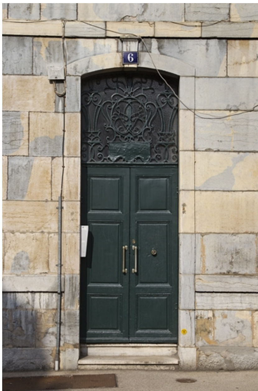
Façade antérieure : détail de la porte d'entrée.
