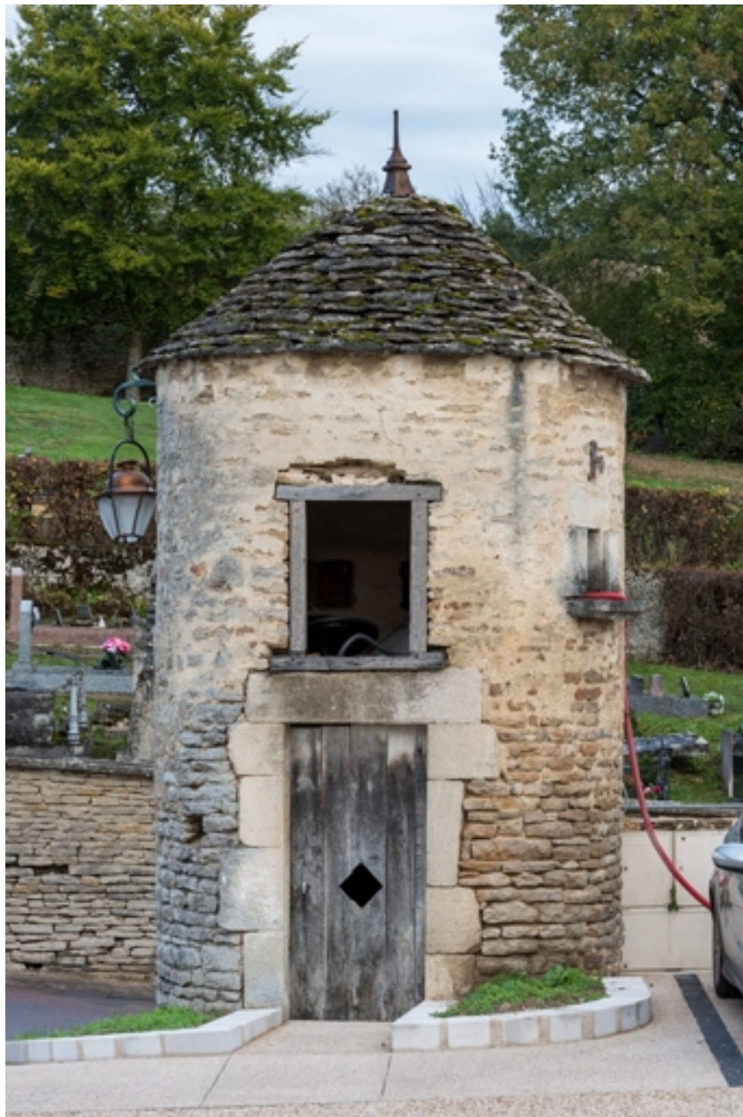
Vue d'ensemble côté sud.
