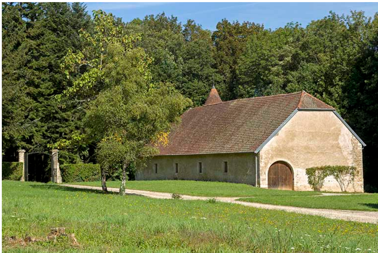
Vue générale du cuvage.
