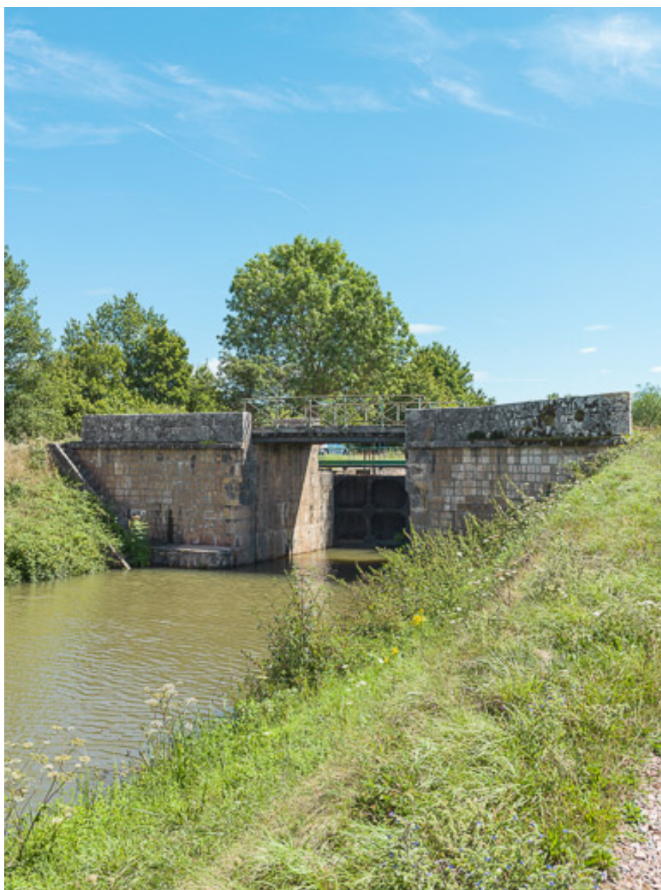
Vue d'ensemble du pont.
