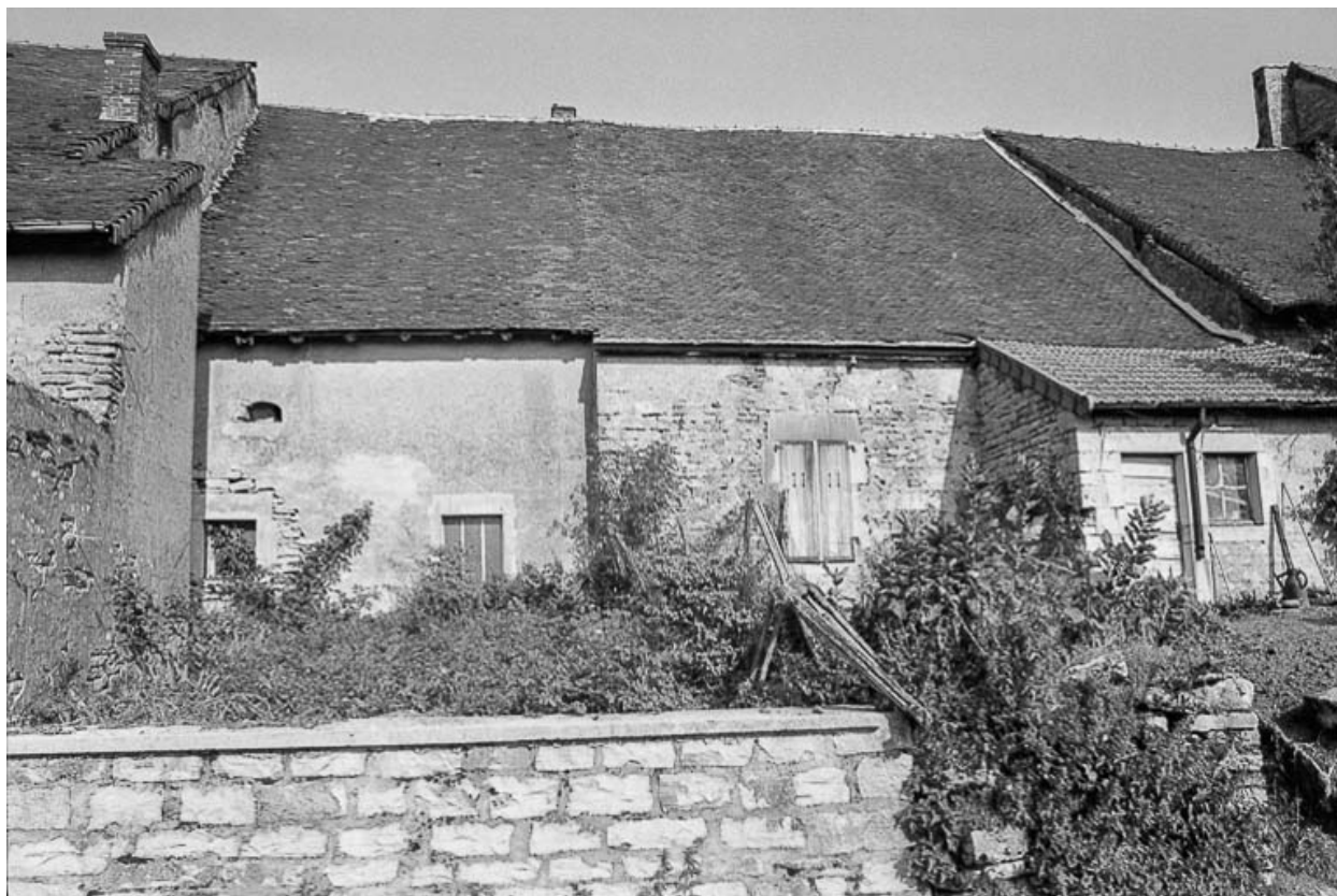
Fermes cadastrées D2 293 et 294 : façades postérieures.
