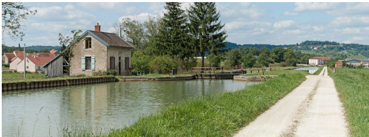
Vue du site d'écluse depuis l'amont.
