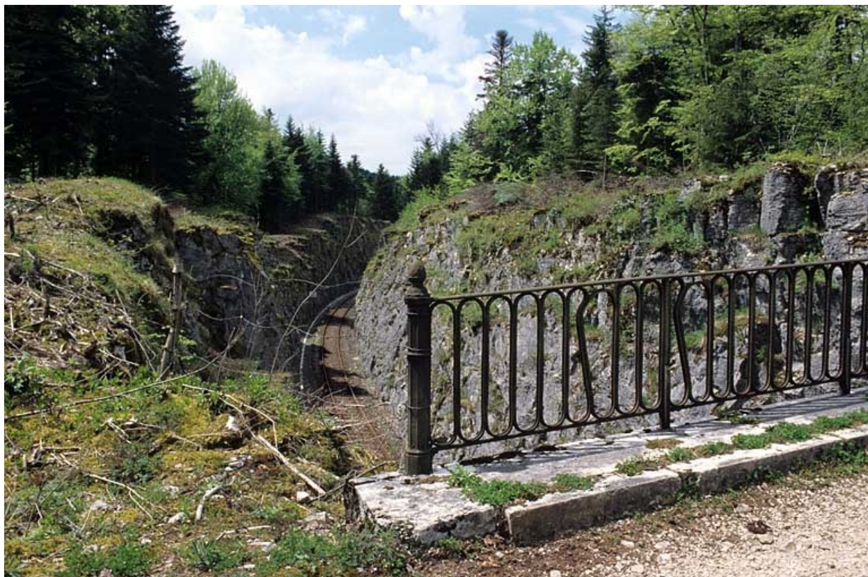
Tranchée côté Andelot-en-Montagne et détail du garde-corps.
