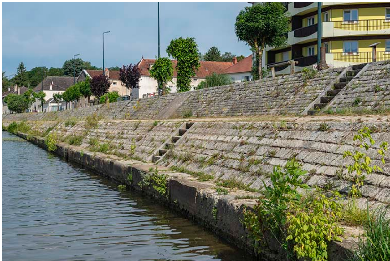
Prologement du quai Villeneuve.
