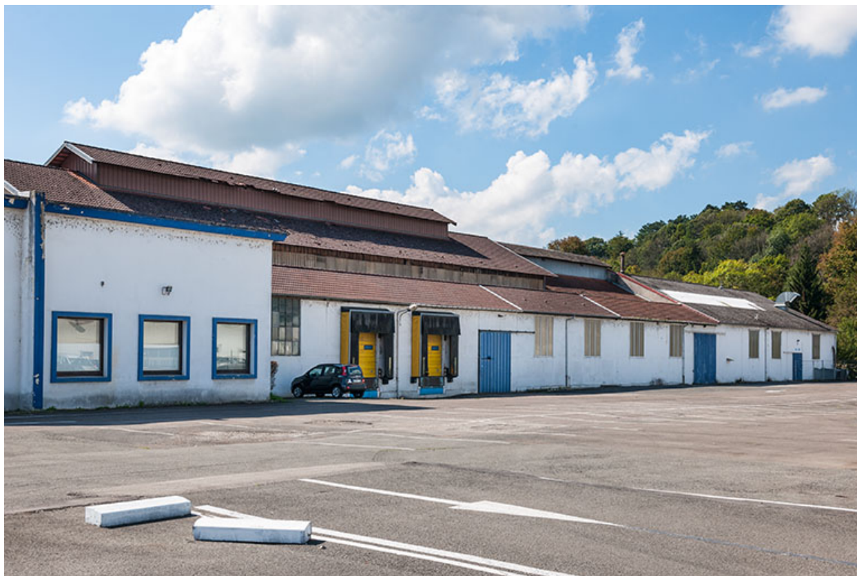
Façade nord vue de trois quarts.
