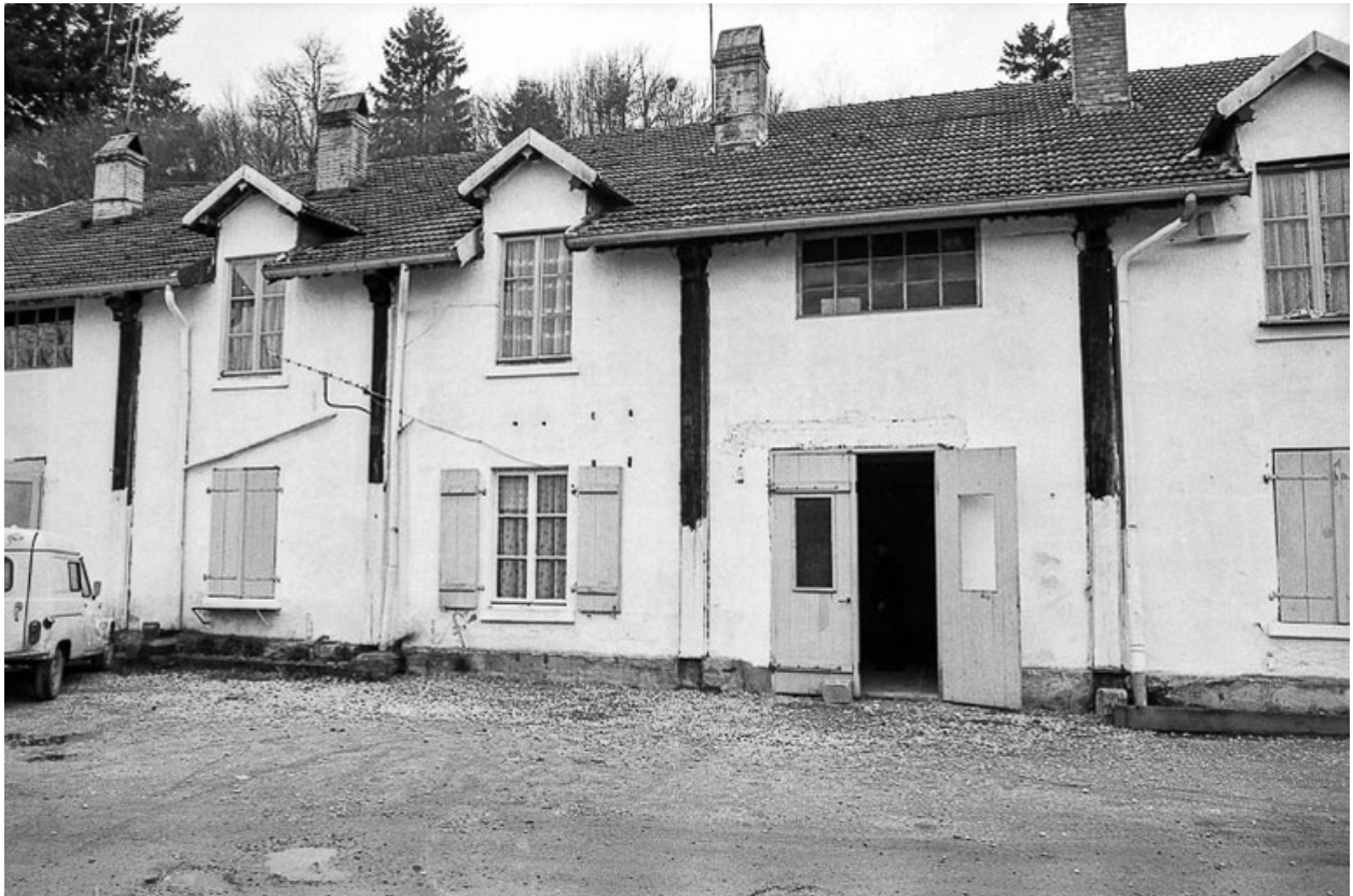
Logements ouvriers dans le site en 1979.
