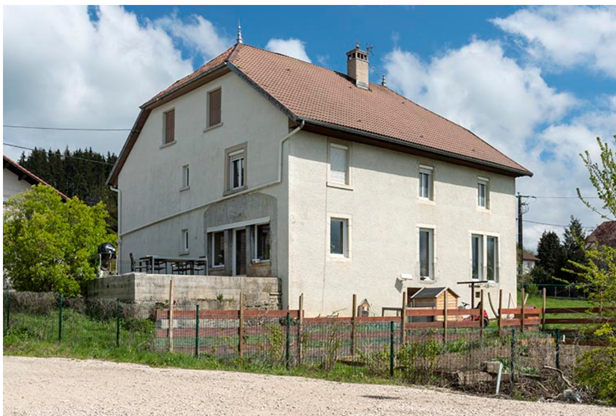
Façades postérieure et latérale droite.
