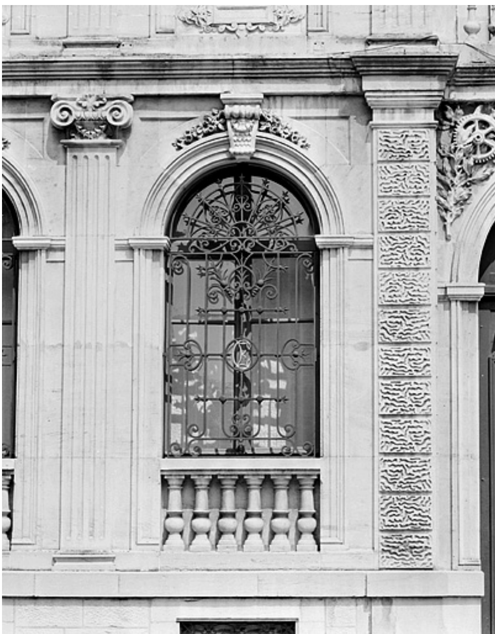
Banque. Façade principale, fenêtre du rez-de-chaussée.
