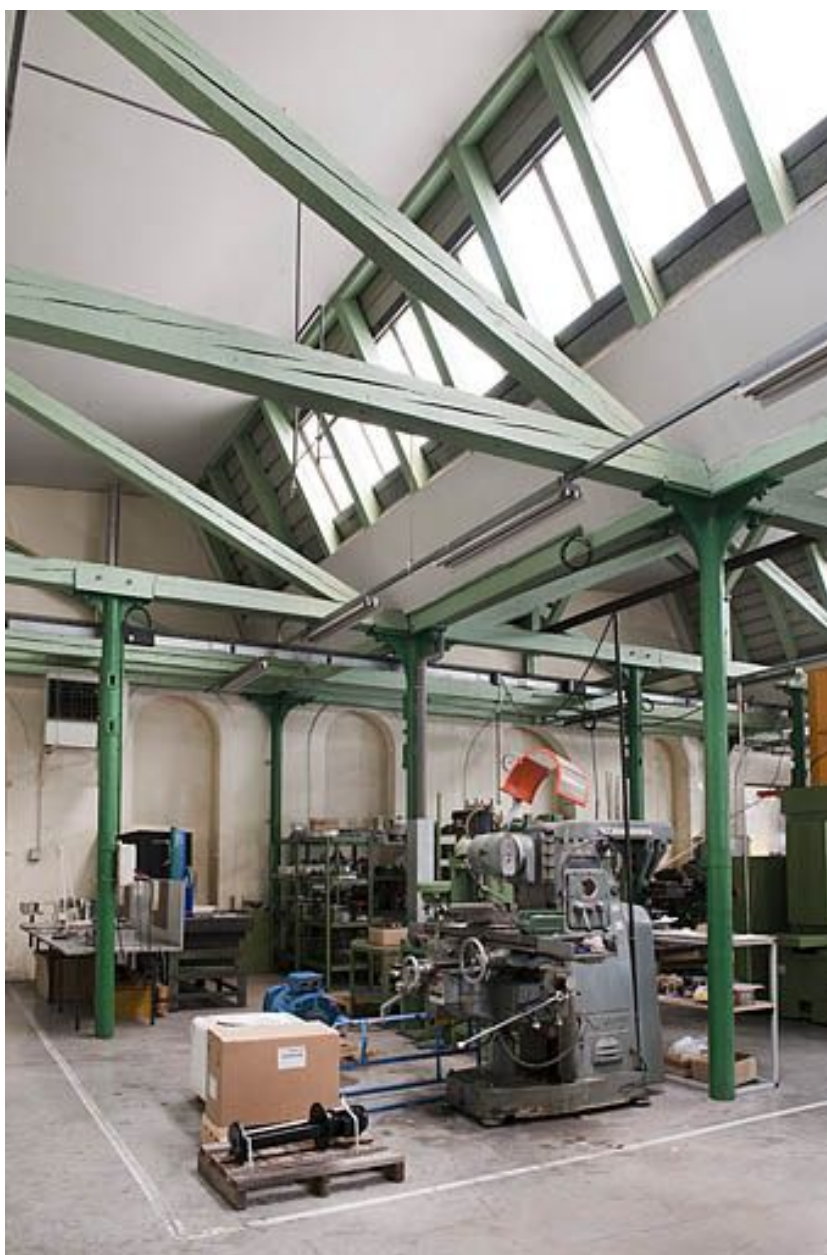
Atelier d'outillage. Détail de la charpente.
