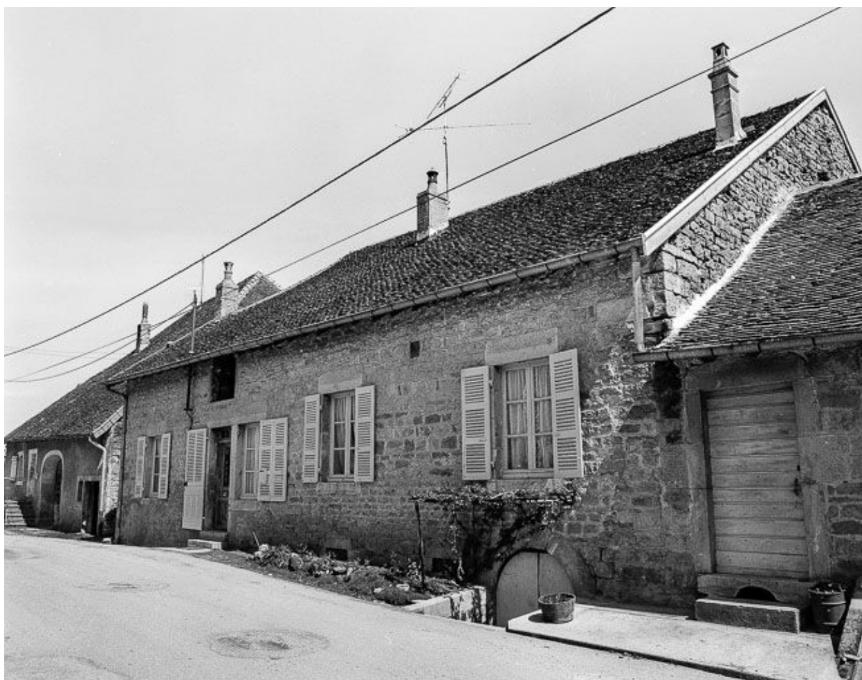
Fermes situées rue du Dessous.
