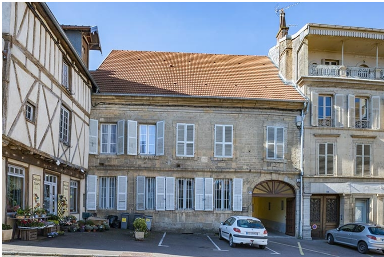
La façade de la maison.
