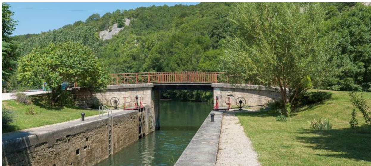
Pont vu du sas.
