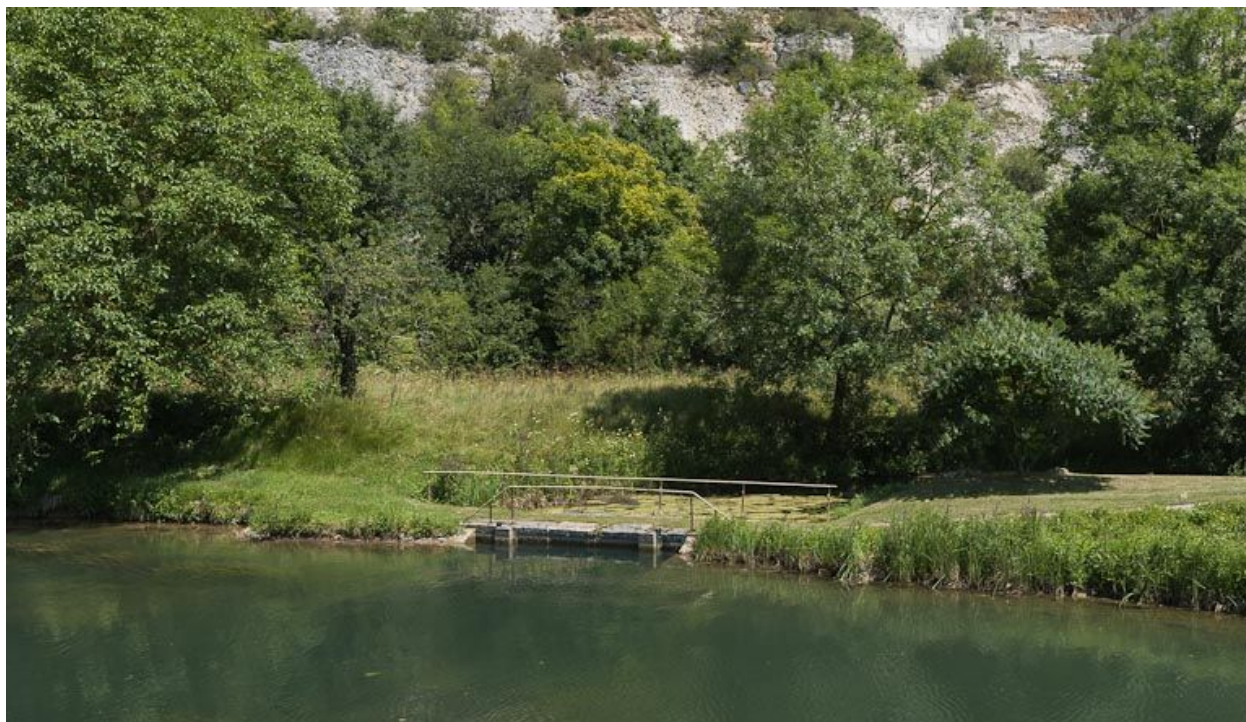
Arrivée de la rigole dans le canal.
