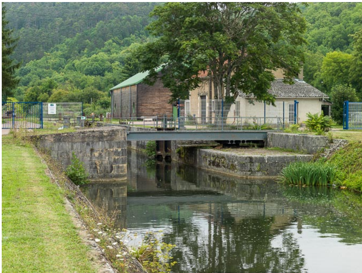
Vue du pont.
