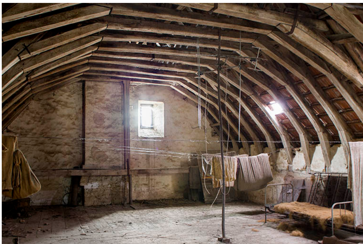
Vue générale de la charpente.
