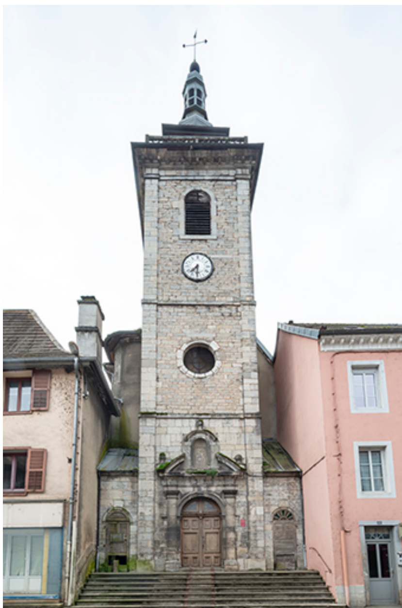
Elévation nord du clocher de l'église.
