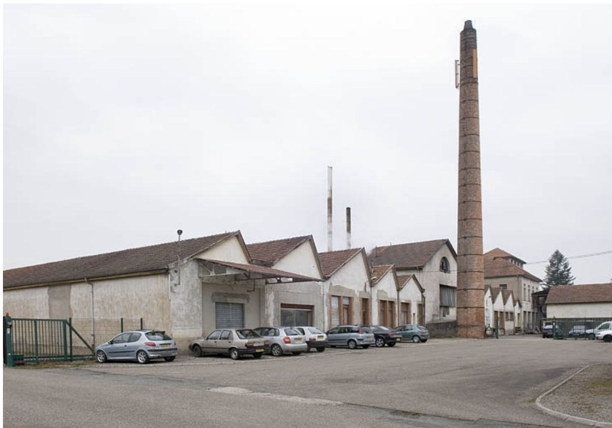
Vue de trois quarts depuis la cour.
