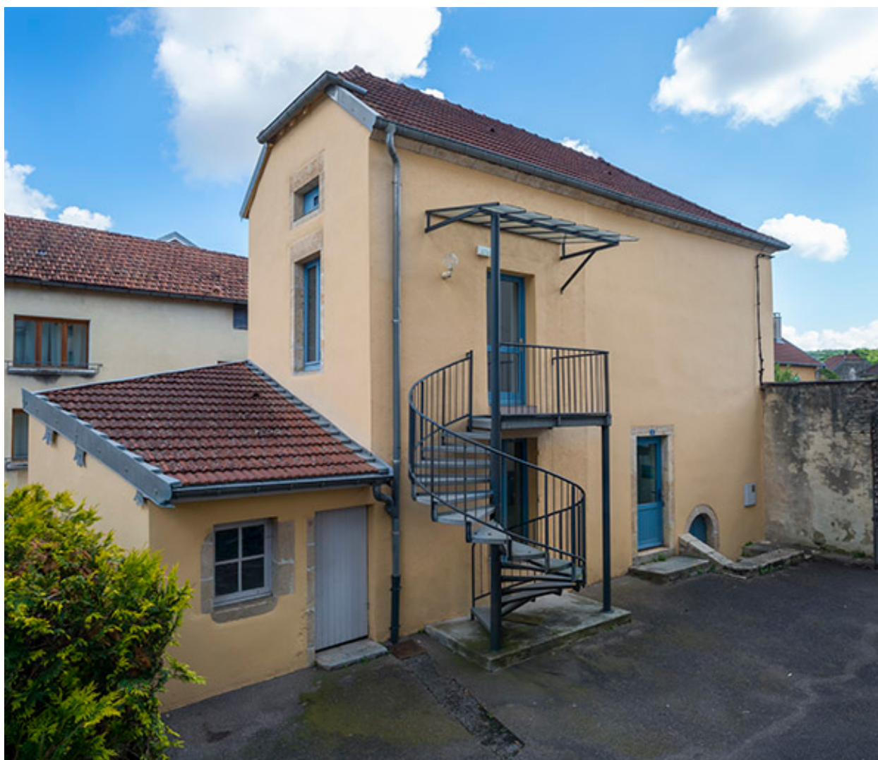
Élévation sur la cour.
