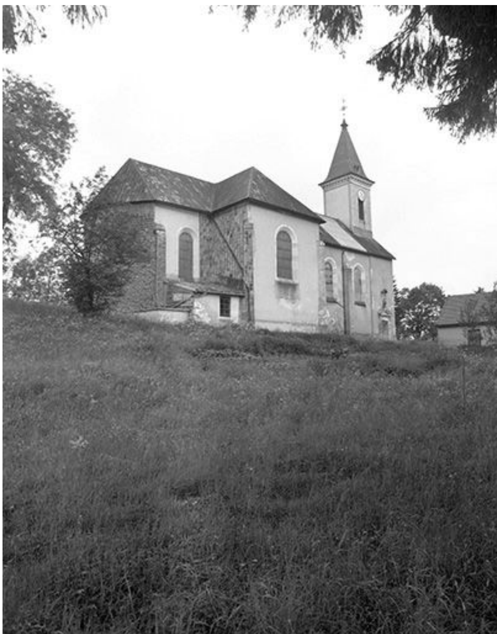
Façade latérale droite.
