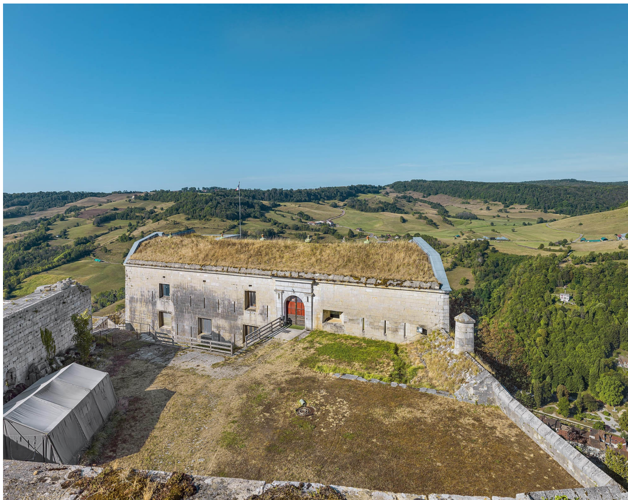
Fort Belin : le réduit.
