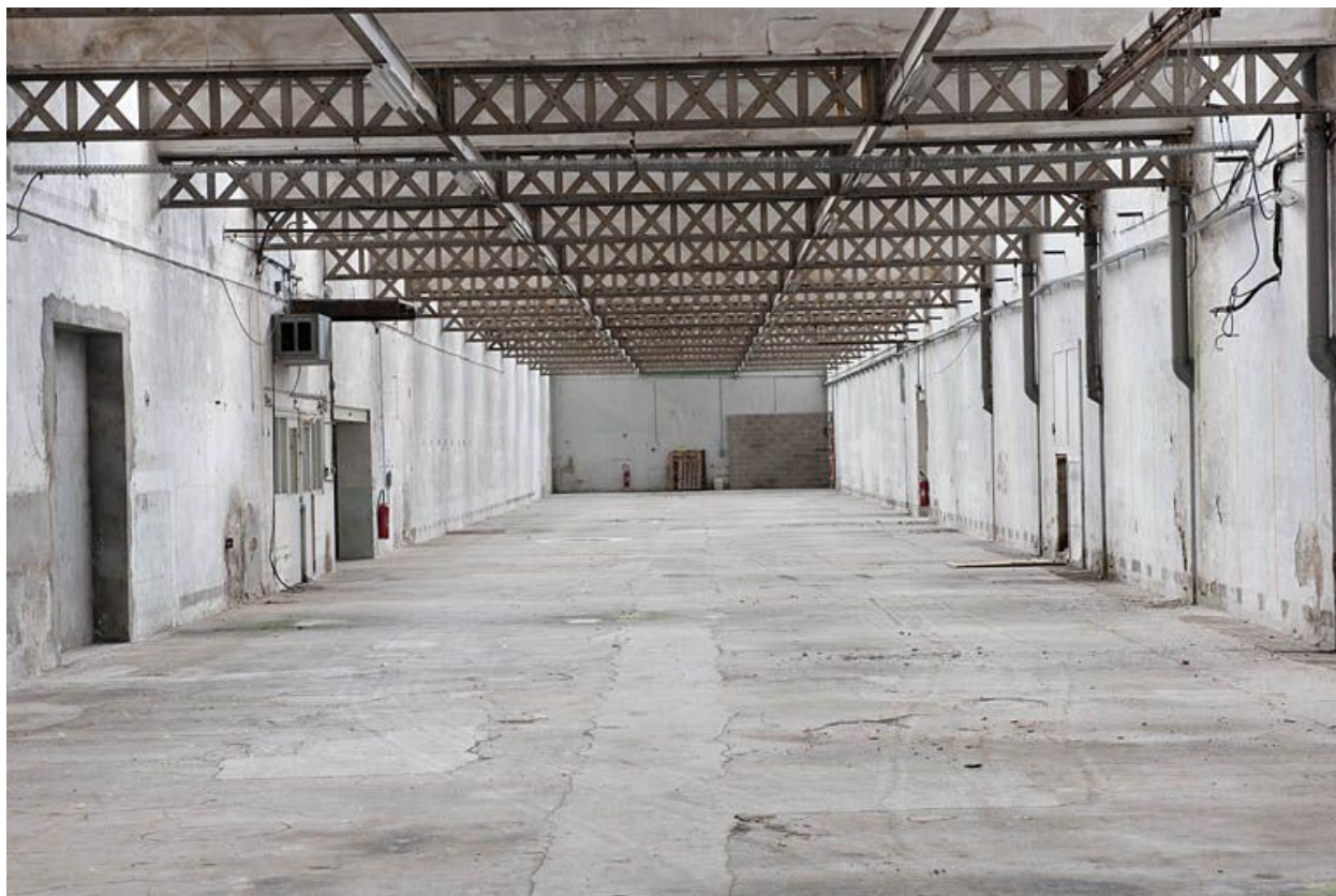
Extension ouest. Vue depuis le sud.
