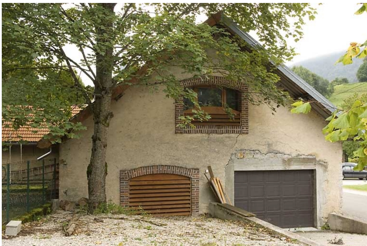
Usine : façade latérale gauche.
