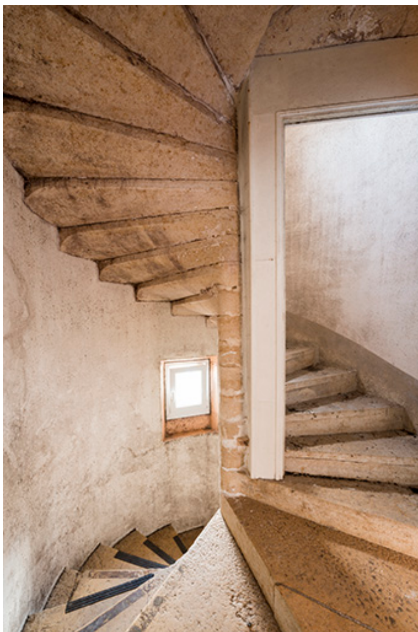
Escalier à vis, situé dans la tour.
