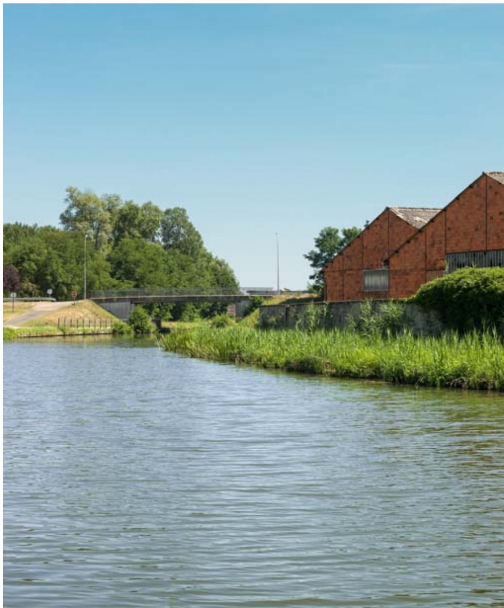
Vue générale du pont et du site.
