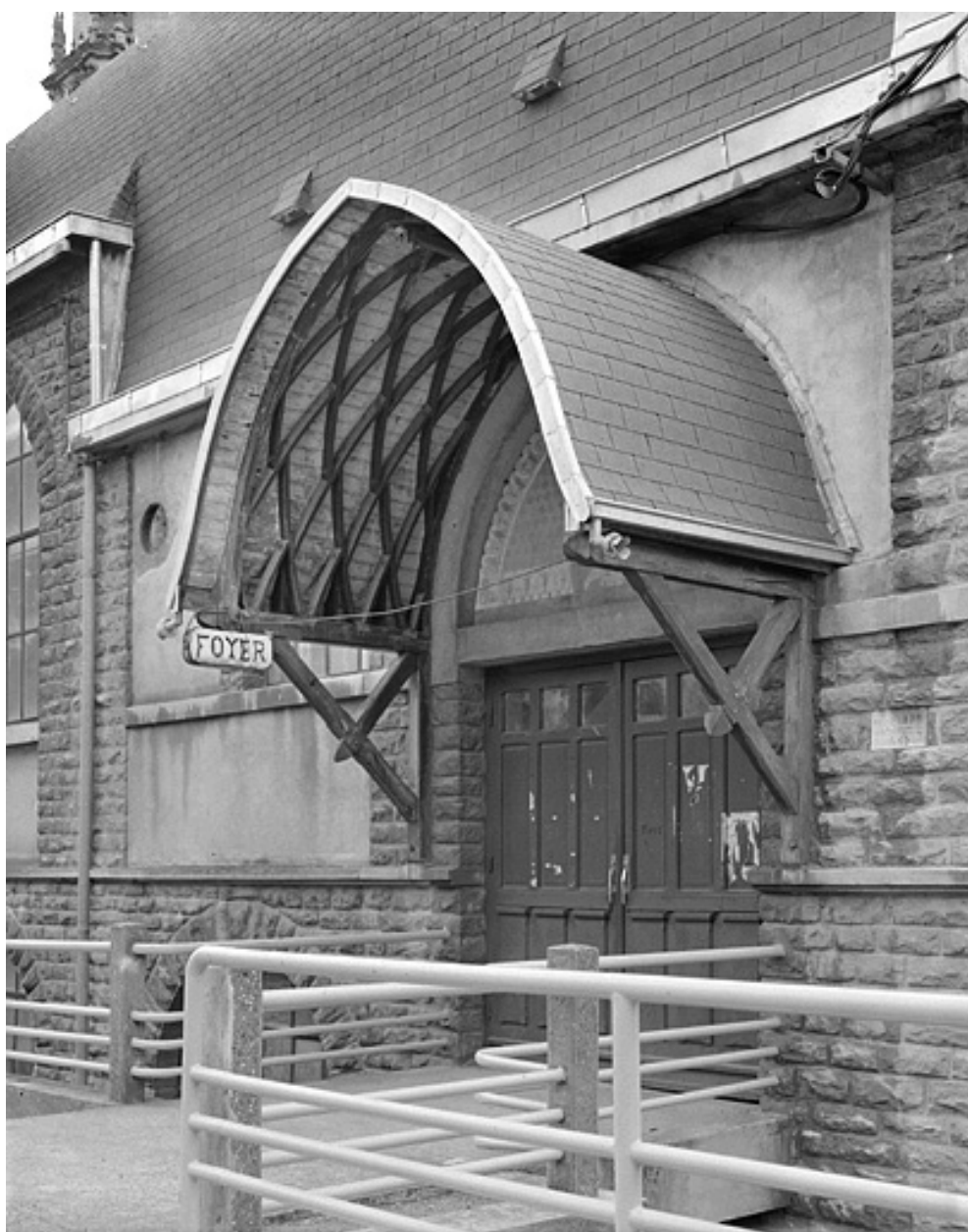
Entrée du gymnase.
