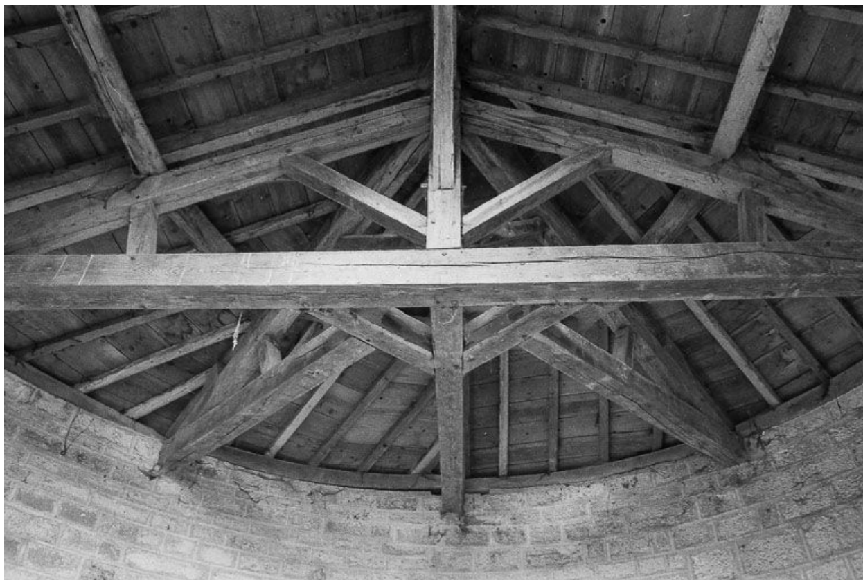
Détail de la charpente.
