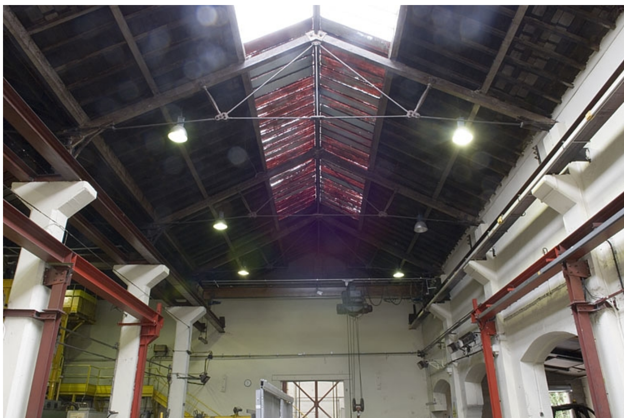
Intérieur de l'atelier et charpente Polonceau.
