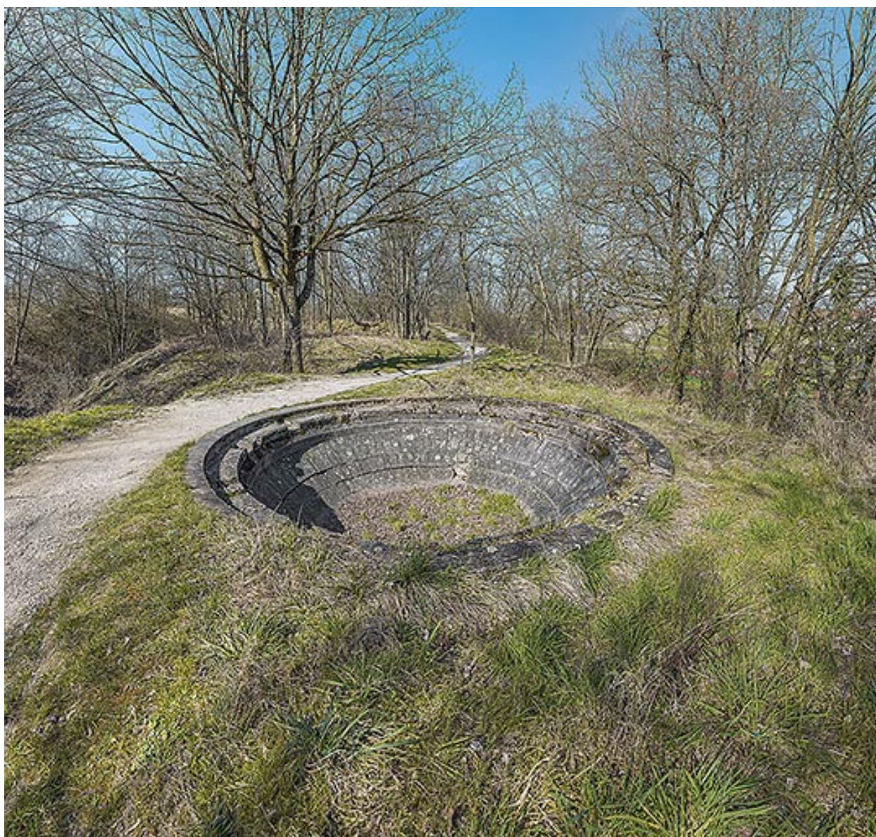
Redoute de Saint-Apollinaire : cuve d'une batterie anti-aérienne.
