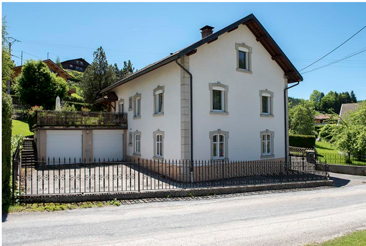
Façades postérieure et latérale gauche.
