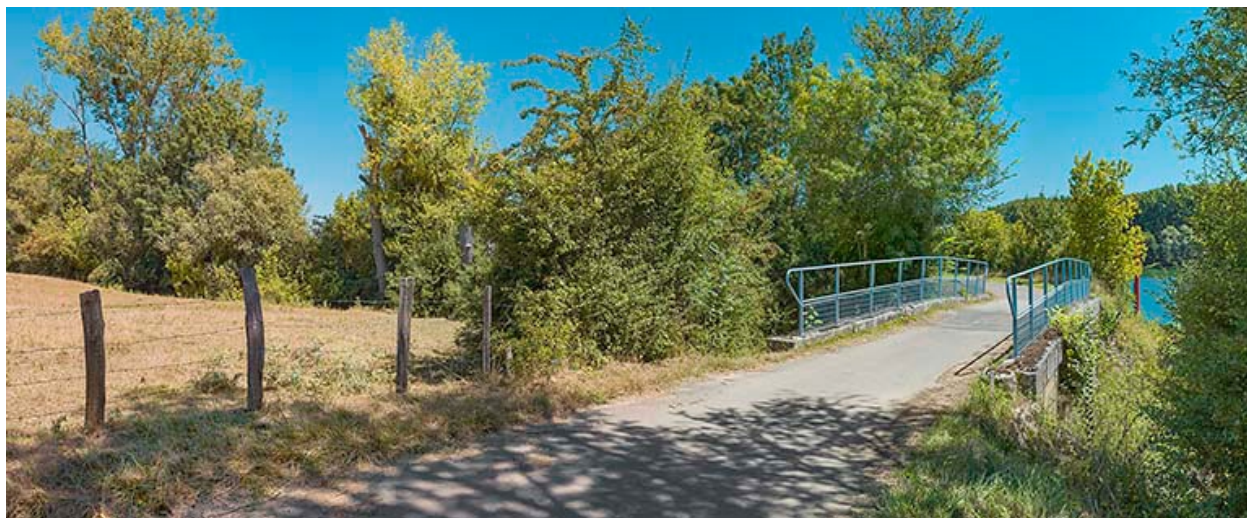
Vue d'ensemble, d'aval.
