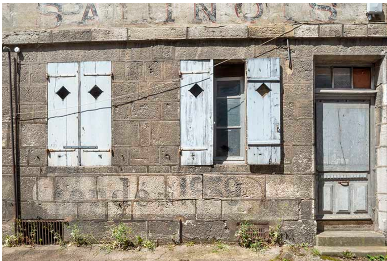
Façade rue d'Orgemont. Rez-de-chaussée des travées nord.
