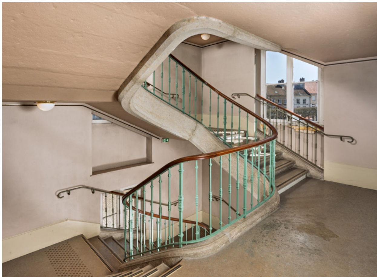
Escalier côté cour : un palier.
