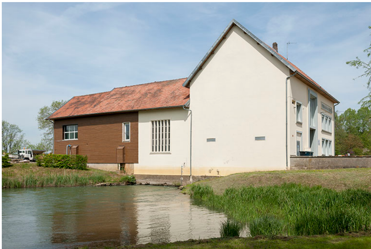
La centrale hydroélectrique vue depuis le sud.
