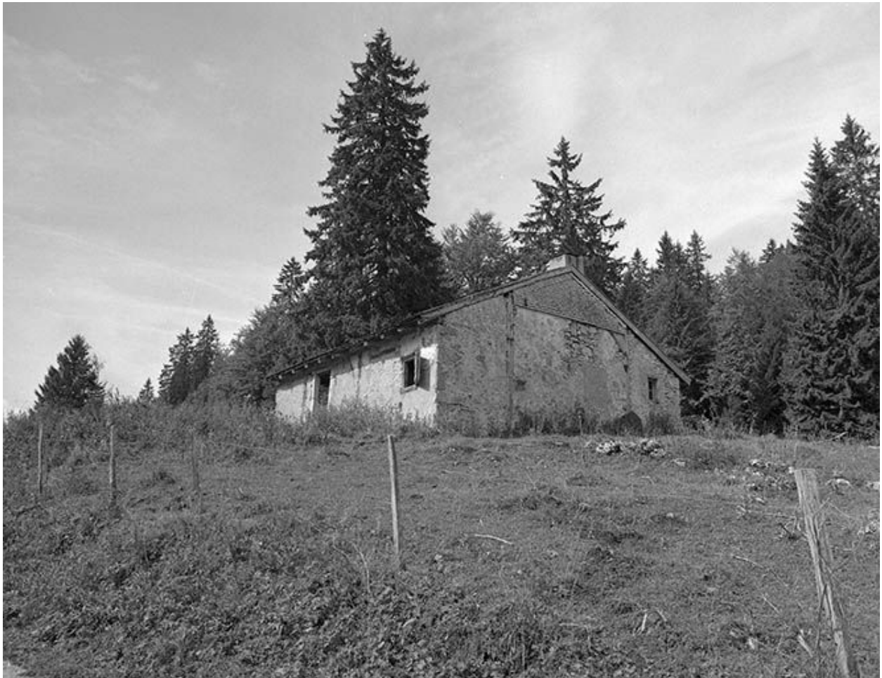
Façade antérieure et face droite.
